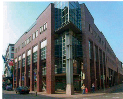
Das Sparkassengebäude in Neumünster – ein Objekt aus dem Fair Value-Portfolio mit 32 Gewerbeimmobilien.
